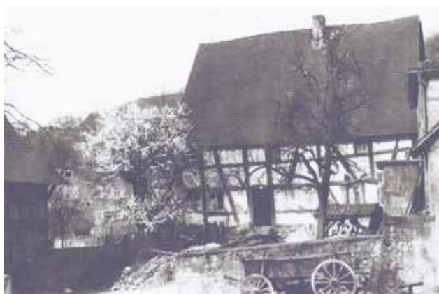
Das Haus mit sichtbarem Fachwerk (etwa im Jahr 1952) und im heutigen Zustand. Das Fachwerk soll wieder freigelegt werden.
